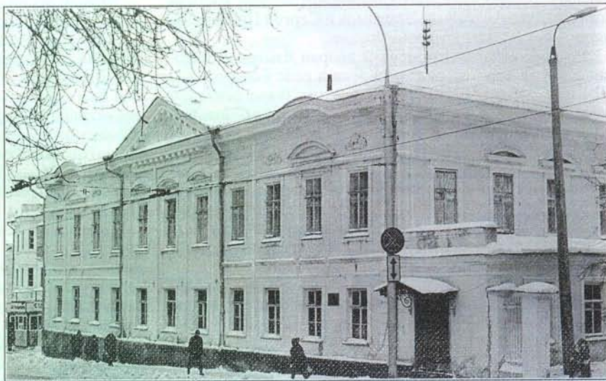
Современный вид дома Ермоловых (ул. Ленина, здание облвоенкомата)
