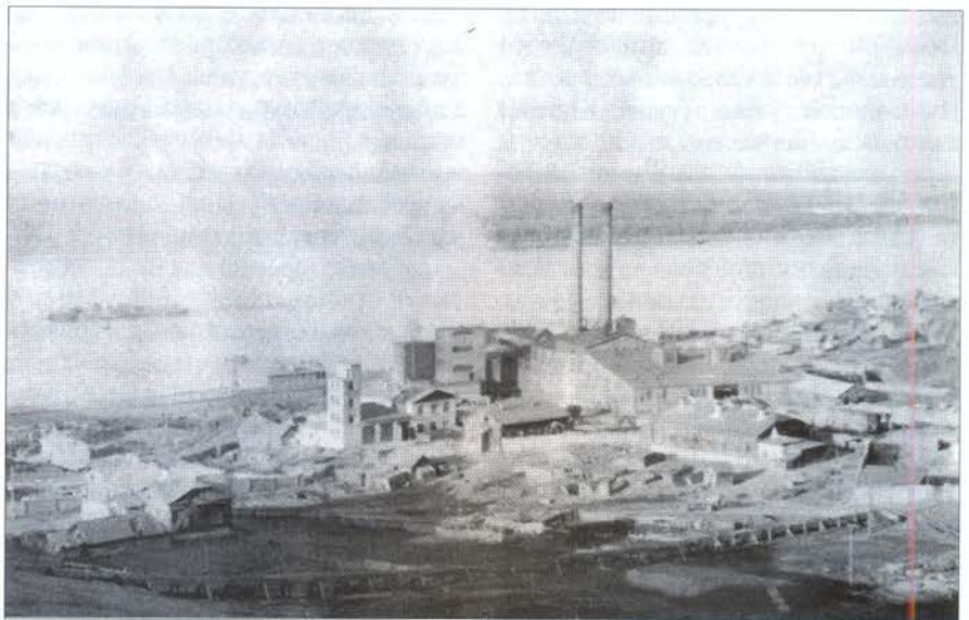
Симбирский бетонный завод
