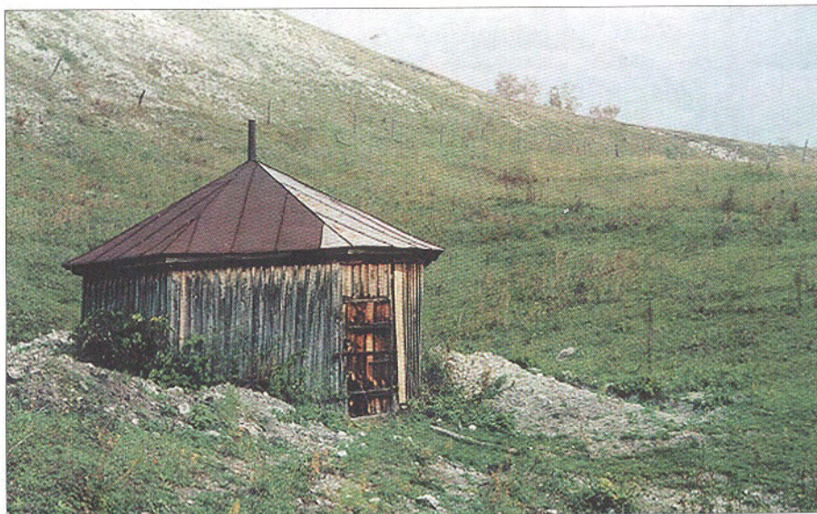
Каптаж («Головка») Сенгилеевского водопровода
