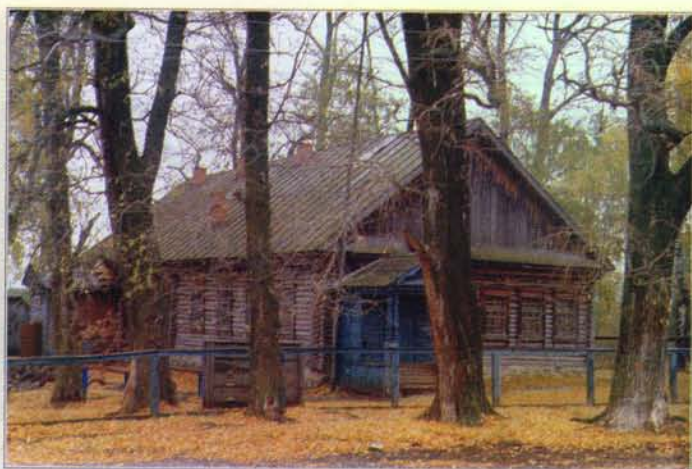
Школа в Сухом Карсуне, построенная на фундаменте разрушенной церкви
