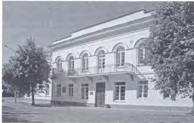
Здание Ульяновского музыкального училища
