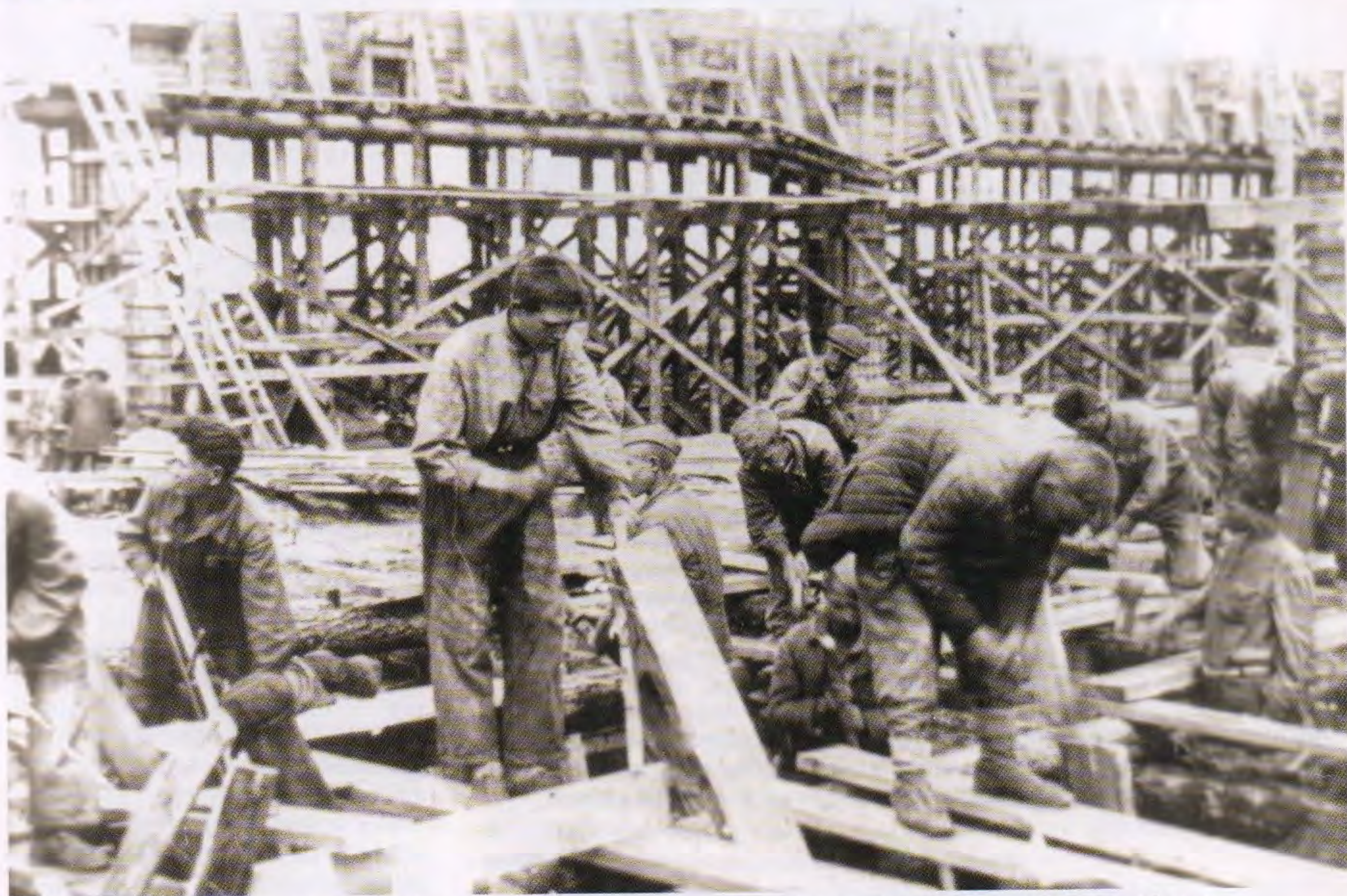
Ульяновский автомобильный завод им. Сталина. Строительство опалубки заводской ТЭЦ. Без даты. г. Ульяновск. Из фондов Государственного архива новейшей истории Ульяновской области.
