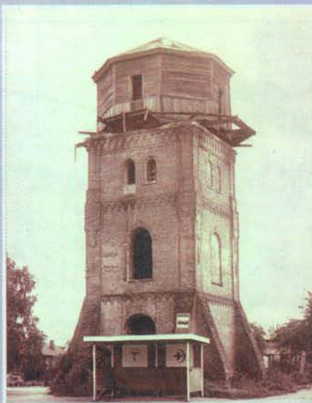
г. Барыш. Старинная водонапорная башня.
