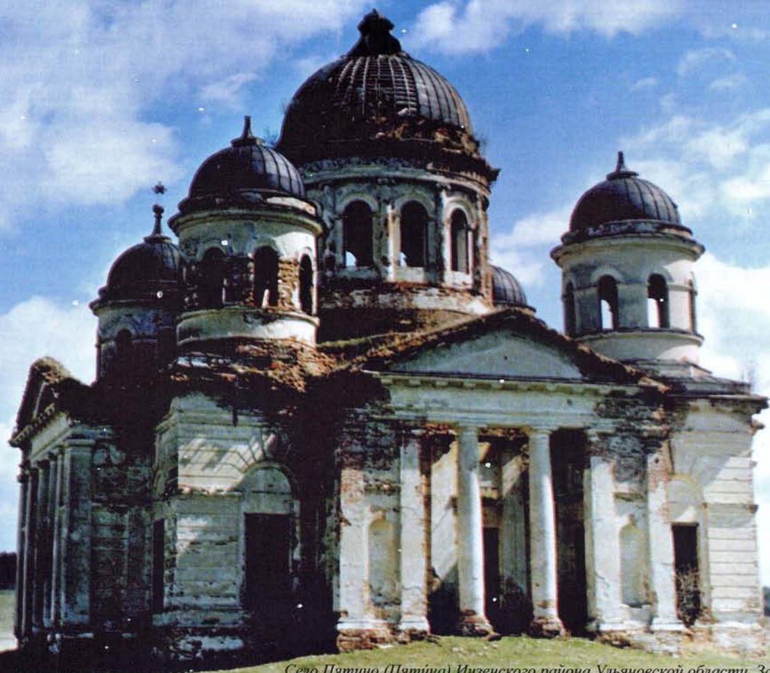
Село Пятино (Пятица) Инзенского района Ульяновской области. Зброшенный и разрушающийся сельский приходский храм, выстроенный в 1823-1832 гг.
