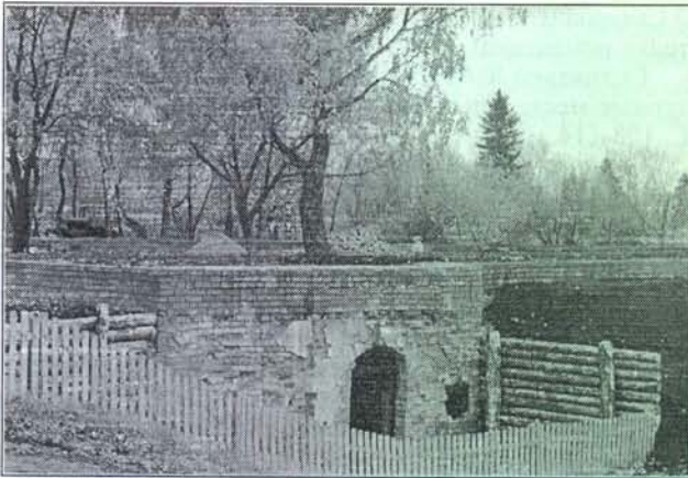
Фундамент дома Языковых
