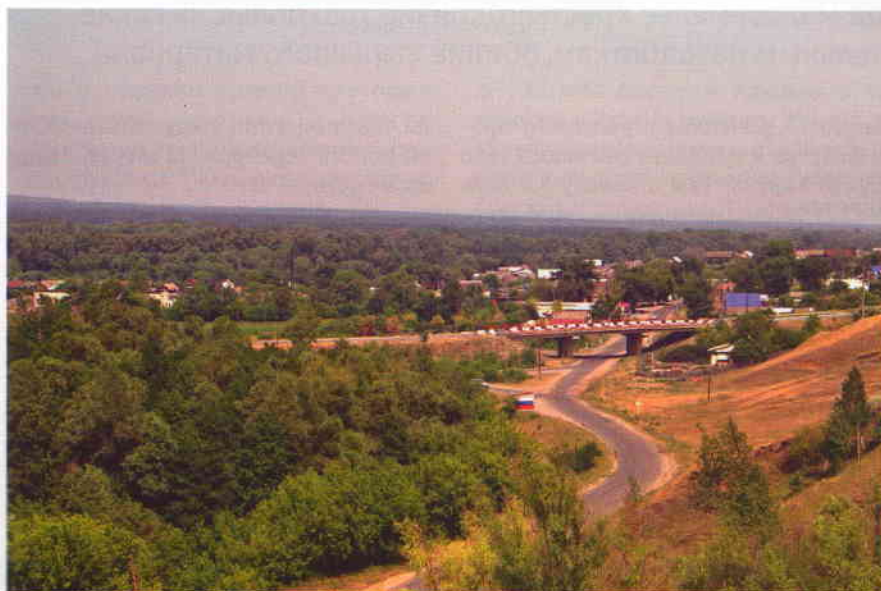
Вид с Маркиной горы на р. п. Новоспасское. Фото М.Г. Матлина
