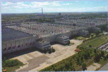
Завод «Авиастар» (филиал компании «Ил») – предприятие по выпуску авиационной техники с полным циклом производства. Он входит в ПАО «Объединенная авиастроительная корпорация» (ОАК) Госкорпорации «Ростех» и специализируется на производстве тяжёлых транспортных самолётов Ил-76МД-90А, сервисном обслуживании транспортных самолетов Ан-124 «Руслан», изготавливает компоненты пассажирского самолёта МС-21, осуществляет гарантийное и послегарантийное обслуживание авиационной техники.
