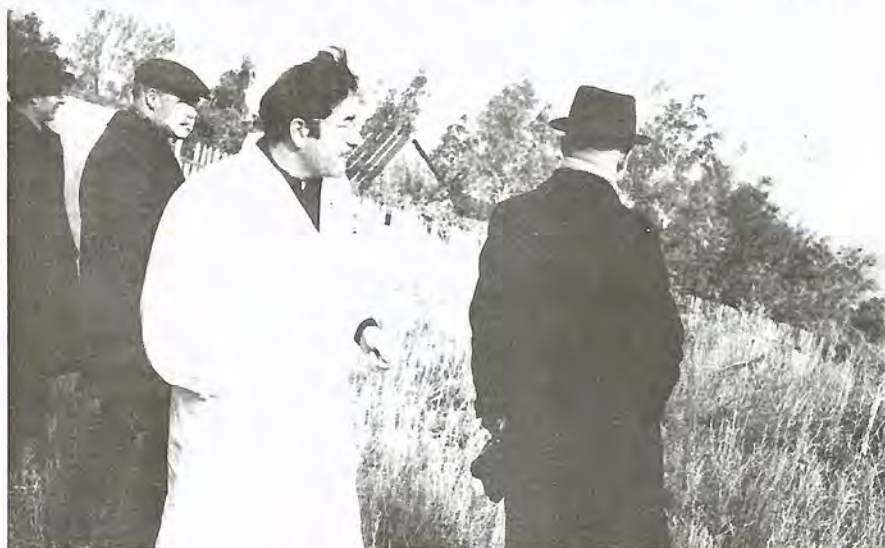
Главврач Халфин (в белом халате) с сотрудниками осматривает оползневый берег, 1970–1972 годы
