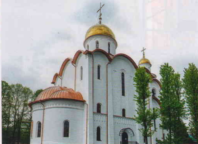
Строящийся храм Святого Благоверного Князя Александра Невского
