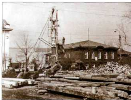
Реконструкция города. Снос старого жилого массива
