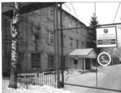
Здание СГРЭ на ул. Доватора в Ульяновске
