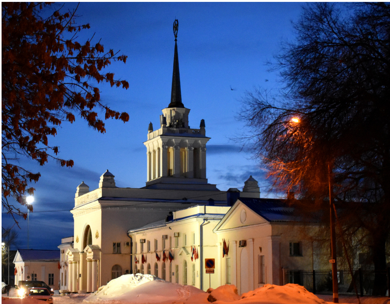
Здание железнодорожного вокзала «Ульяновск-1». Январь 2021 г. Фото А. Ю. Шабалкина.
