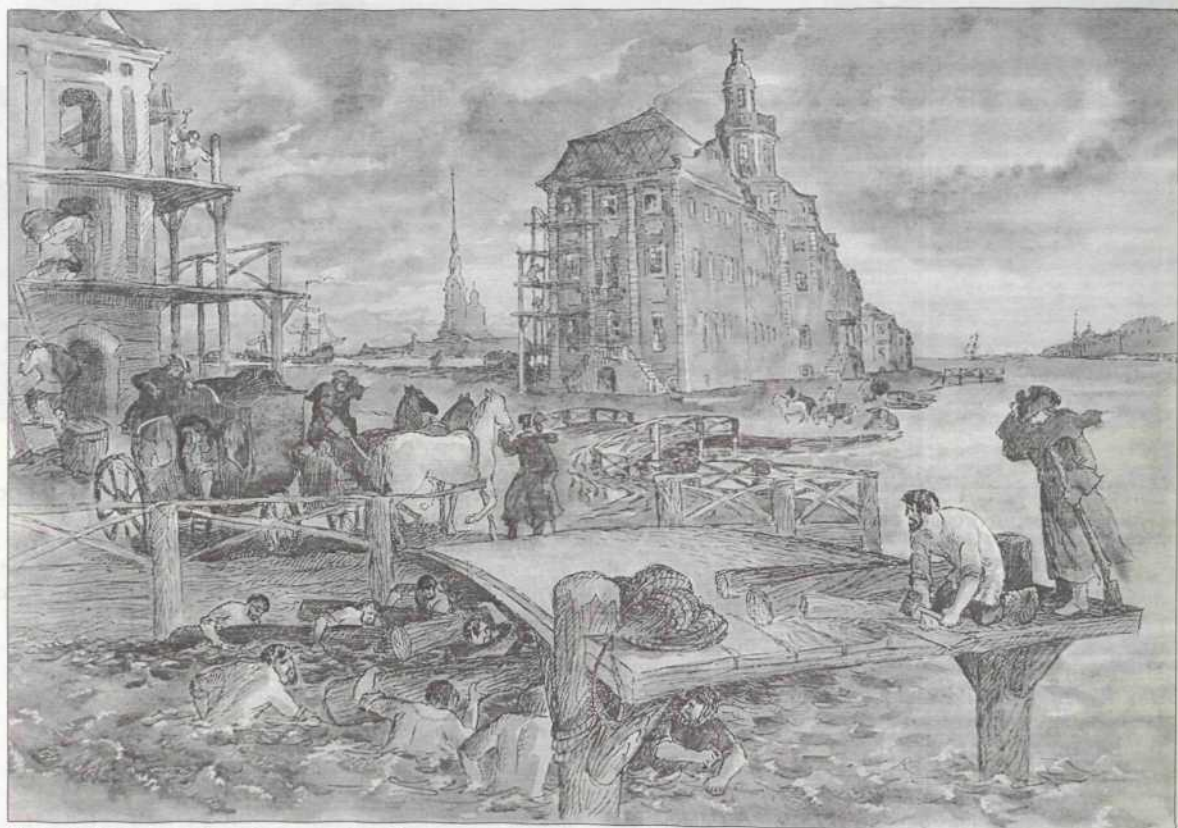
Андрей Кузнецов. Строительство на Васильевском острове в XVIII веке
