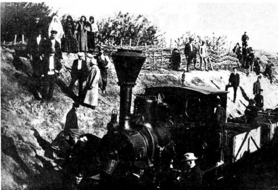
рельсы укладывались на земляное полотно без балласта – материала для верхней части строения пути (например, щебня). Железнодорожное полотно покрывалось им только после нескольких лет эксплуатации.
